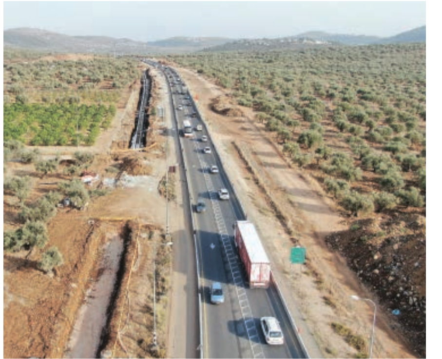
הרחבת כביש 85 כרמיאל
